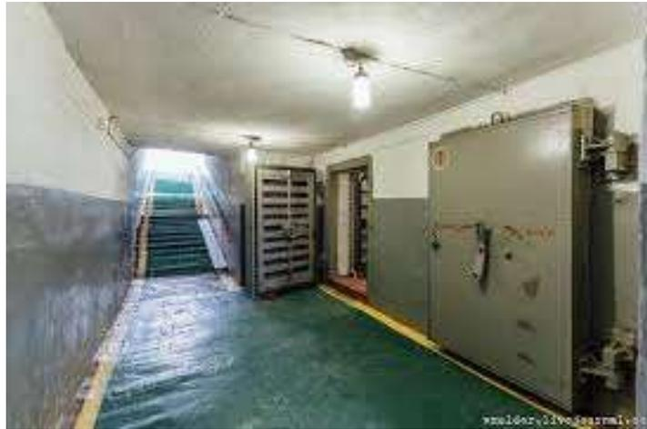
**Убежище – защитное сооружение гражданской обороны**, предназначенное для защиты укрываемых в течение нормативного времени от расчетного воздействия поражающих факторов ядерного и химического оружия и обычных средств поражения, бактериальных (биологических) средств и поражающих концентраций аварийно химически опасных веществ, возникающих при аварии на потенциально опасных объектах, а также от высоких температур и продуктов горения при пожарах.
